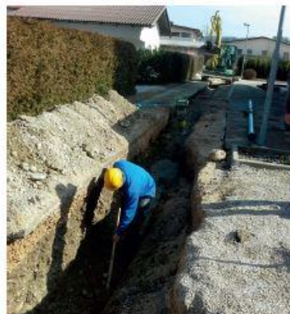
Izgradnja vodovoda na Pibernikovi ulici.
